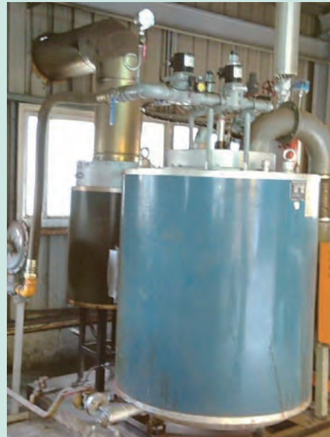
● 重油鍋爐轉換天然氣鍋爐
