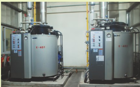
重油鍋爐轉換汰換為天然氣鍋爐
